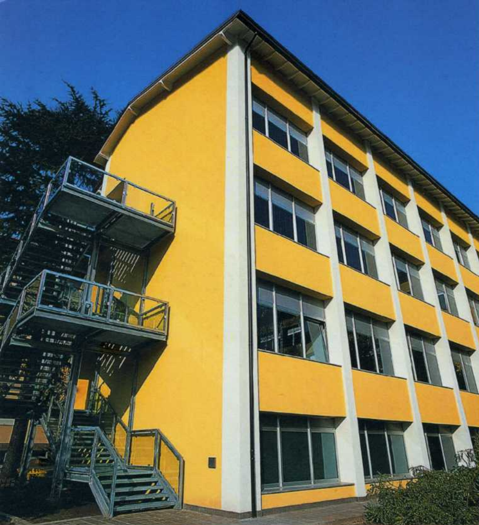
Serramenti in alluminio e scala di sicurezza.
