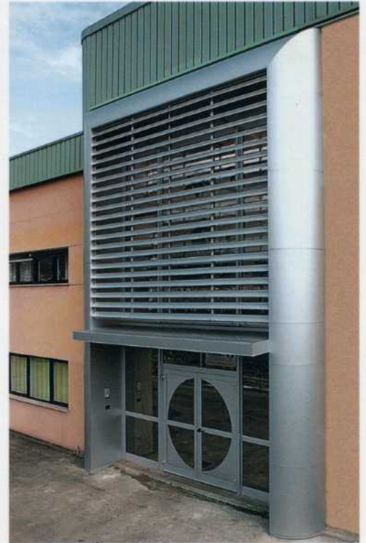
Ingresso con imbotti semicirculari e frangisole in alluminio.
