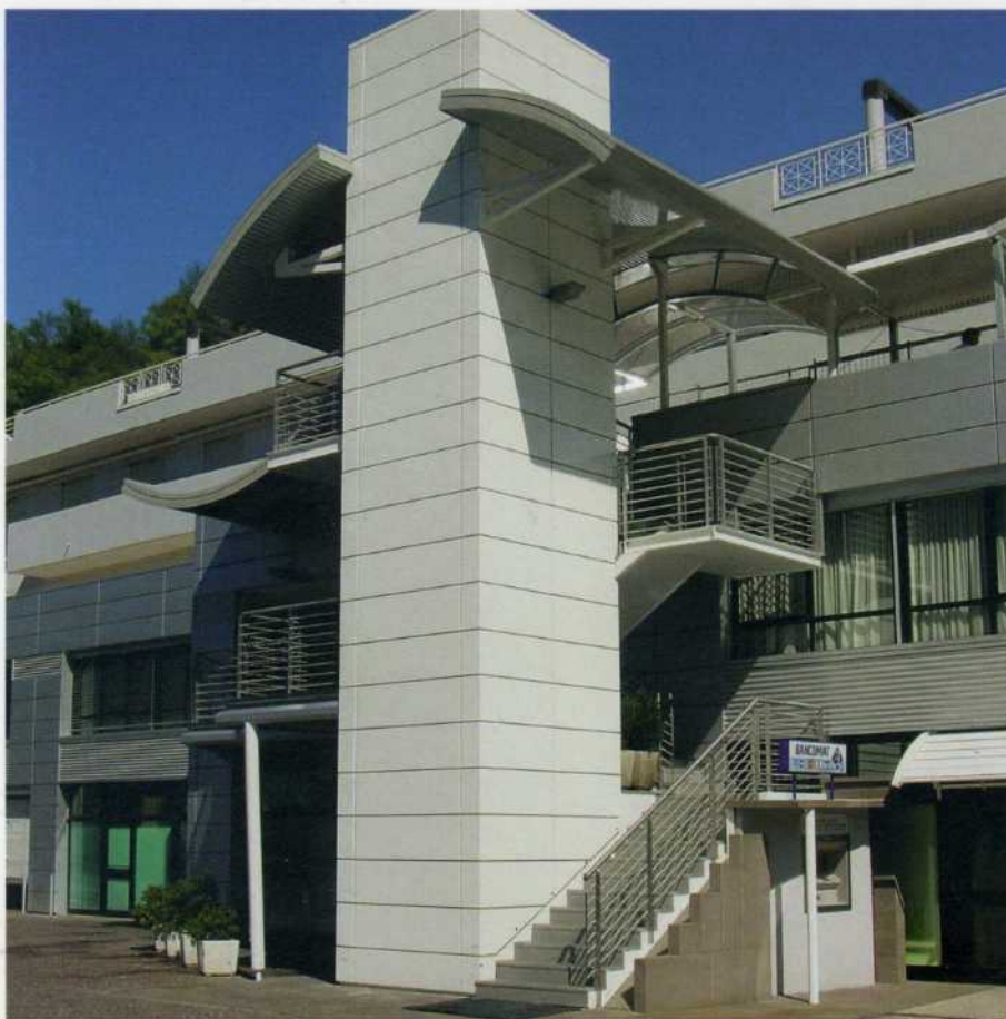
Rivestimenti in alluminio e opere di carpenteria speciali.
