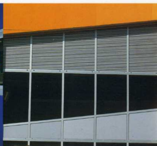
Parete modulare con inserimento di grigliati.
