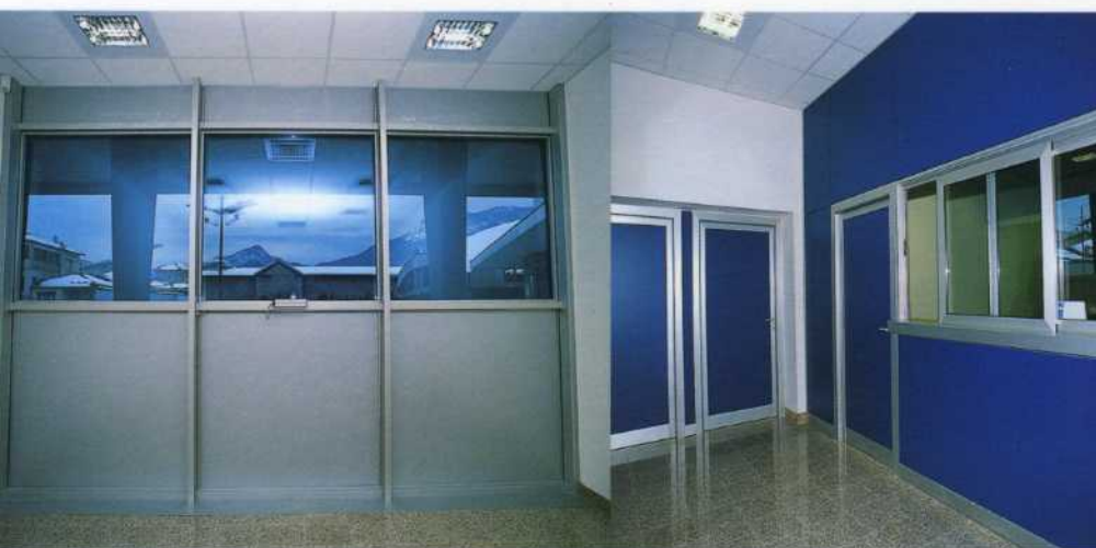
Interno di facciata strutturale.
